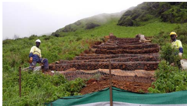
Contrôle de l'eau de ruissellement sur la R201
