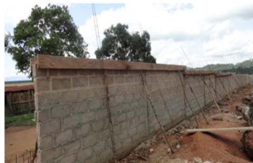
Construction de la cours de l'école de Lola
