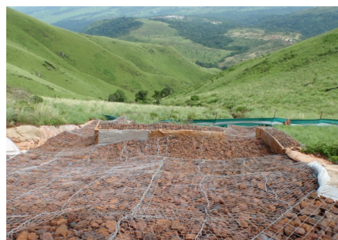
Construction de Gabion et Renovation de cascade le long du R201
