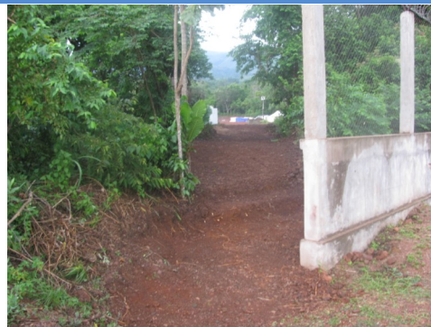
Construction d'un trottoir reliant la grande cour au grand magasin
