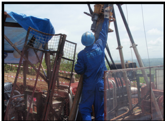
Travail de Forage
