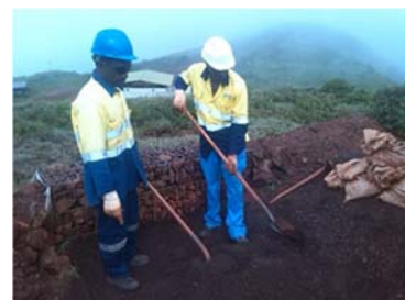
Désédimentation des bassins de décantations
