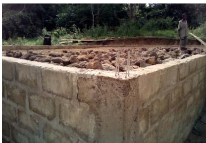
Construction à Bourata
