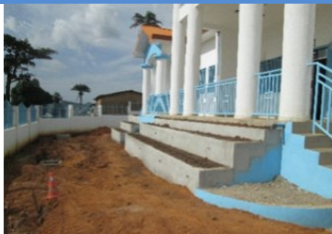
Construction de parterres de fleurs à la devanture du bâtiment
