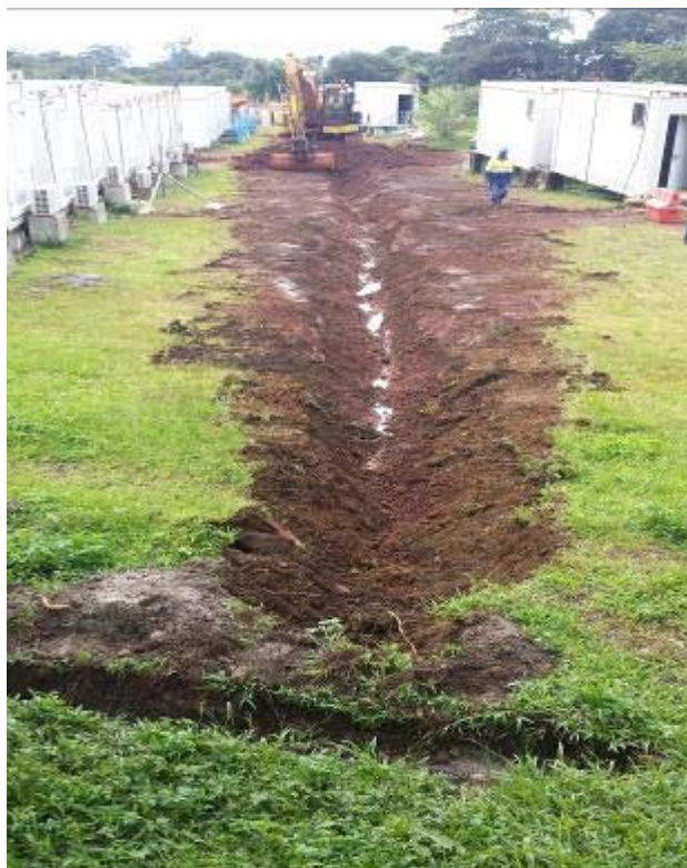
Tranchée de câble entre le Kiosque 2 et la buanderie
