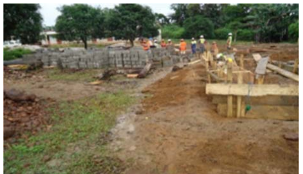
Site de construction du Projet de Bossou
