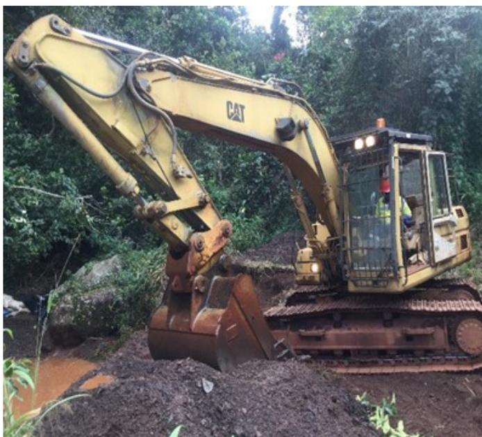
Travaux de de-sédimentation mécanique a la rivière Zié
